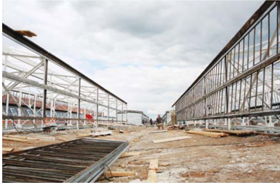
Несмотря на непредвиденные обстоятельства, связанные с пандемией, завод реализует все планы по ремонту и реконструкции корпусов
